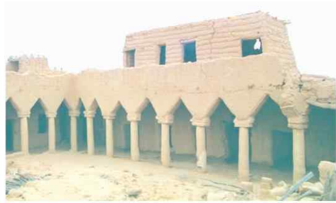
الشكل (٣) البيوت الشعبية في منطقة نجد والمنطقة الوسطى
