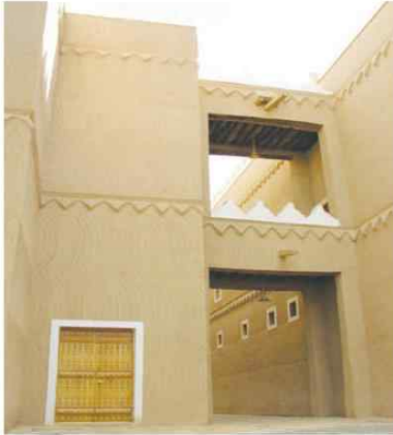
الشكل (٢) البيوت الشعبية في منطقة المربع بالرياض
